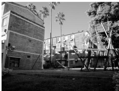
La terminación exterior del edificio es de ladrillo visto, la cubierta es inclinada con terminación de membrana, las paredes interiores están terminadas con revoque terciado y los pisos con cerámica, aunque no lograron colocar la cerámica en todos los espacios de acceso a los bloques. El cielorraso en todas las unidades, al terminar la obra, estaba en rústico, o sea que la losa estaba vista.
